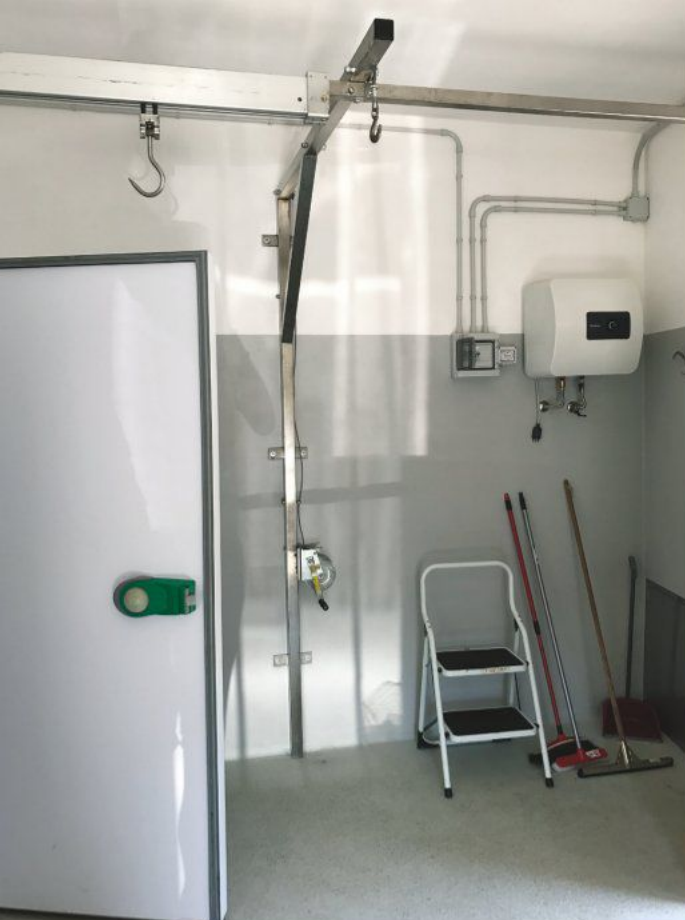
Area dedicata all'ispezione all'ingresso della cella di sosta, con rotaia di trasporto.
