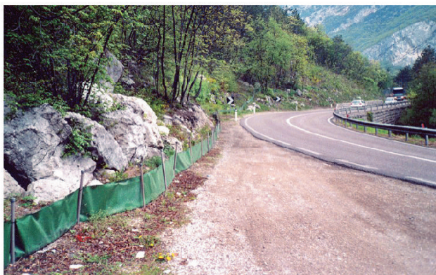
Foto 2 e 3: barriere attraversamento anfibi (sottopassi)
